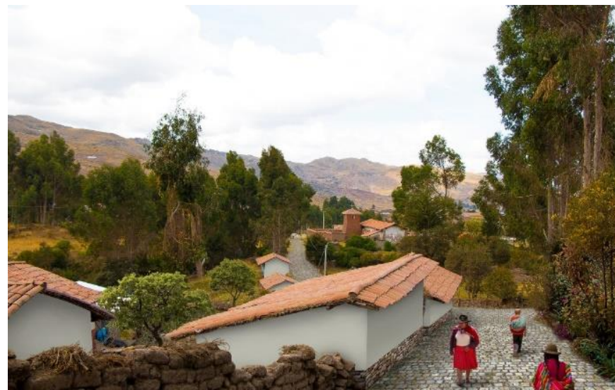
Vista de las calles con tratamiento para la transitabilidad del centro poblado de Cusibamba. Elaboración: Equipo Técnico EU Cusibamba 2018-2028.
