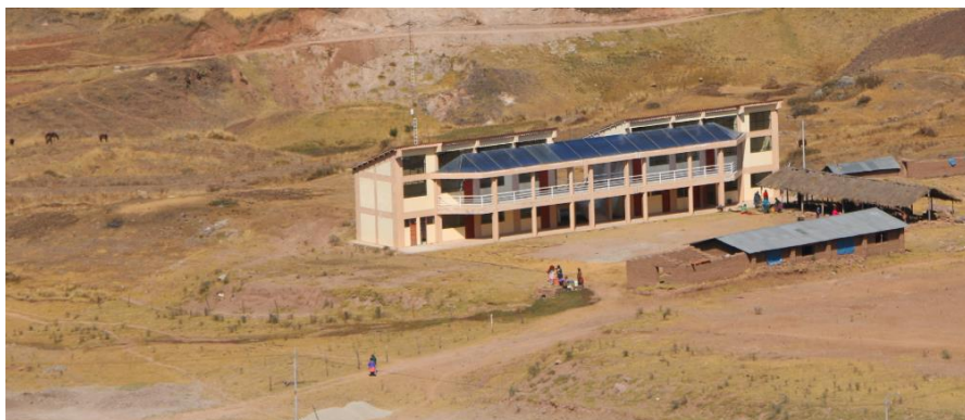
Vista de la edificación prevista para el funcionamiento de la I.E. Secundaria del centro poblado de Cusibamba, 2018-2028.
